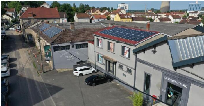
Les panneaux sont en cours d'installation sur les toits de la manufacture Perrin. Ils vont permettre à l'entreprise d'être autonome à 35 %. Photo fournie par Planète plus
